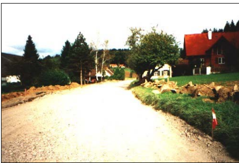
Baustelle bei der Familie Leitgeb
