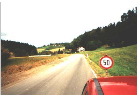
Beginn der Ausbaustrecke
