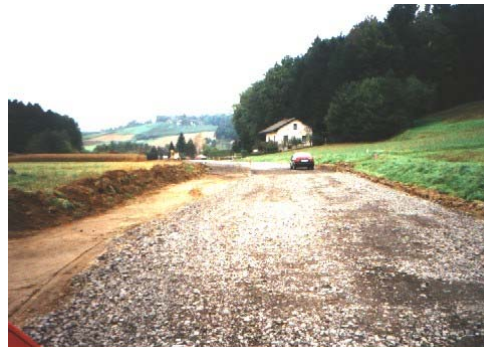
Ausbau zwischen Wieden und Auersbach
