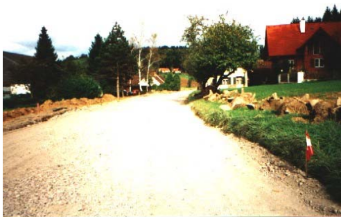
Seit September ist der Ausbau voll im Gange
