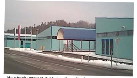
Hausbank verlangt Ausfallhaftung für das Innovationszentrum
