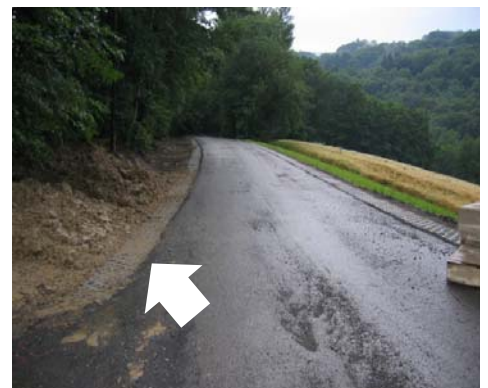
Straßenkanal wurde neu verlegt
